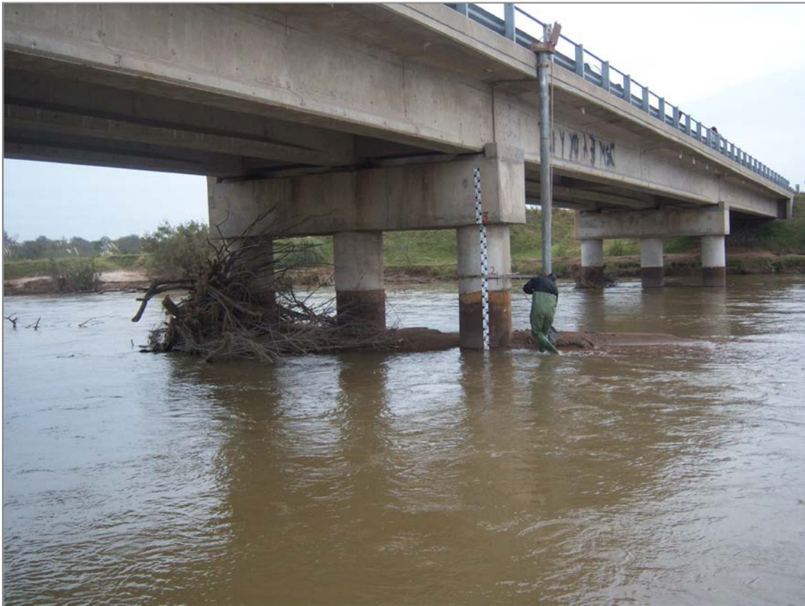
Figura 11: Trabajos de limpieza en la sección de niveles del Río V en Villa Sarmiento.
