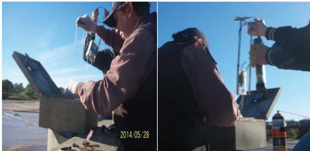
Figura 4: Thalimedes instalado en la sección del puente carretero sobre el Río IV
