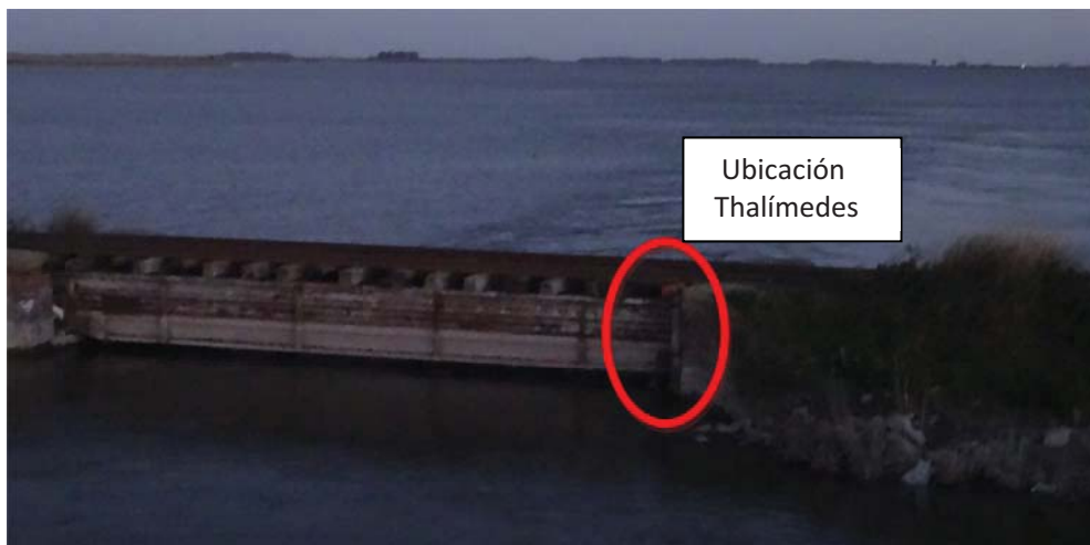
Figura 12: Ubicación de limnómetro sobre Puente Ferroviario en Onagoity.
