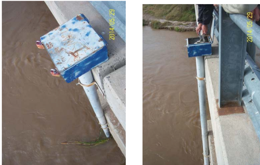
Figura 16: Estación en Puente Carretero sobre Canal Devoto
