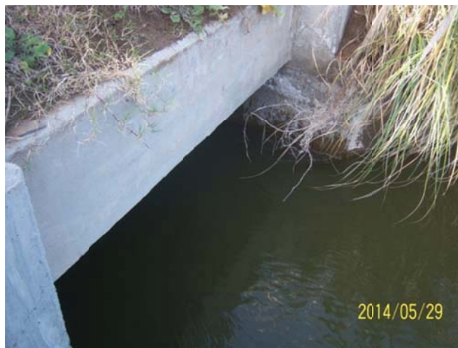
Figura 21: Sección de alcantarillas ubicadas paralelas al puente La Vanguardía.
