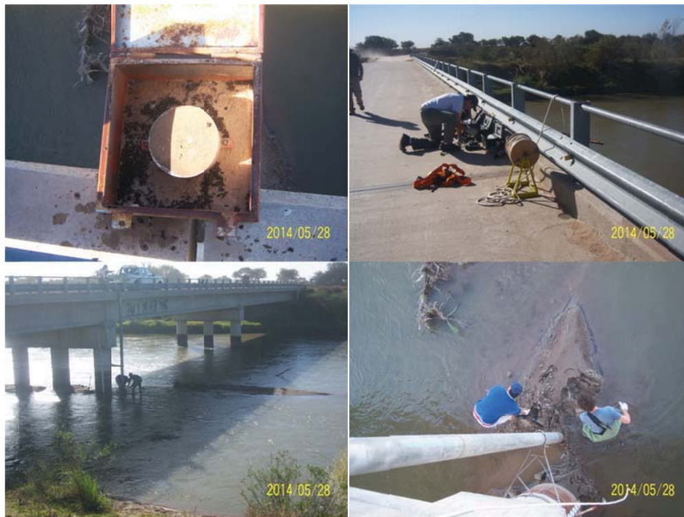
Figura 8: Trabajos de limpieza en la sección de niveles del Río V en Villa Sarmiento.
