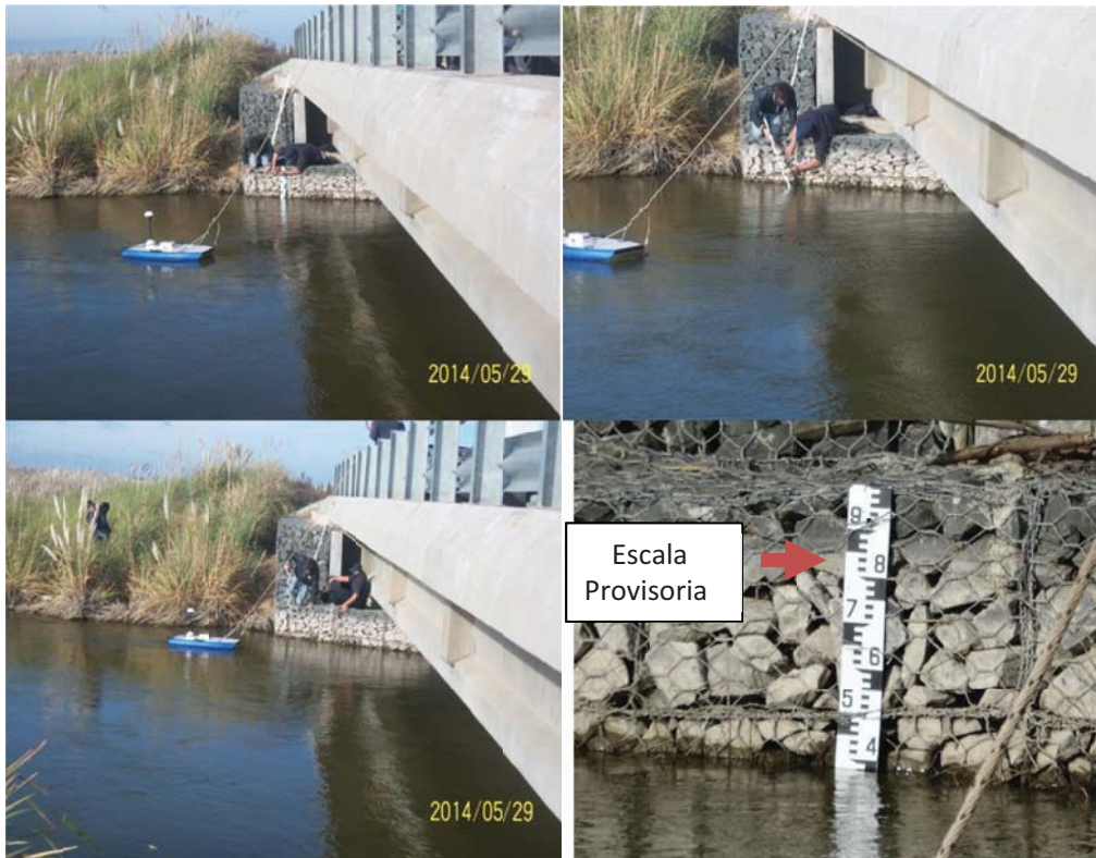
Figura 20: Sección de aforo y ubicación de escala provisoria en Puente La Vanguardía.
